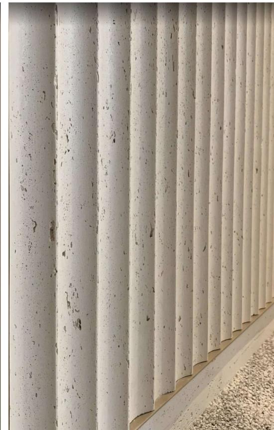
Широкоформатные размеры панелей (идеально подходят без горизонтальной стыковки на потолки до 3 метров в чистом виде)
